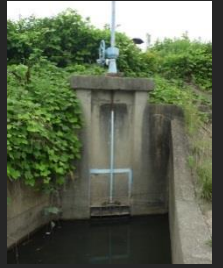
町屋御用水取水口
