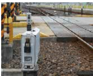
踏切障害物検知装置 東員12号踏切
